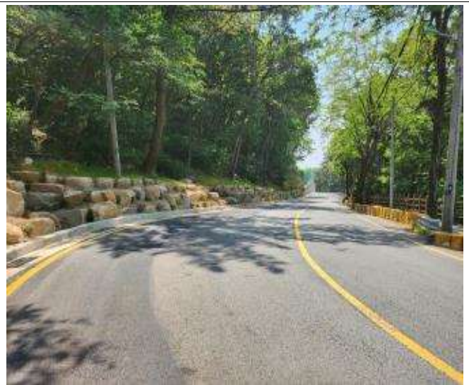
개선 후(보도폭 확장 및 측구설치)
