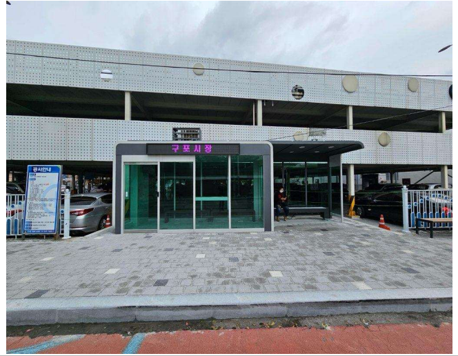
개선 후(보도폭 확장 및 스마트승강장 설치)
