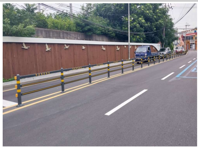
개선 후(무단횡단방지 차선분리대 설치)
